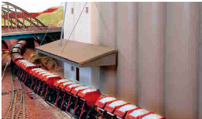
Die neuen Getreidesilos verfügen über einen eigenen Gleisanschluss.
